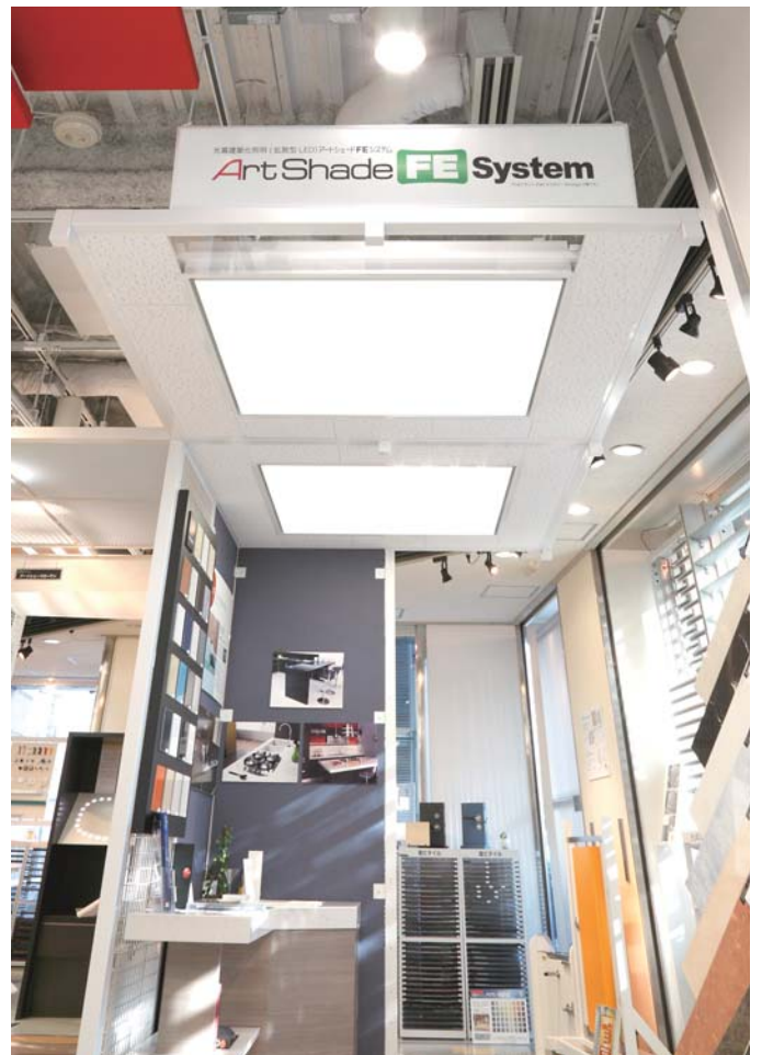
蛍光灯を使用したシステム天井用照明器具。光のムラが発生している。
